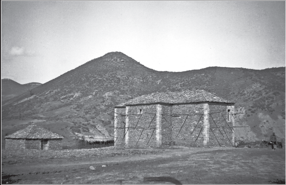
Λιθόκτιστο κτήριο στο Μαλίκ.
